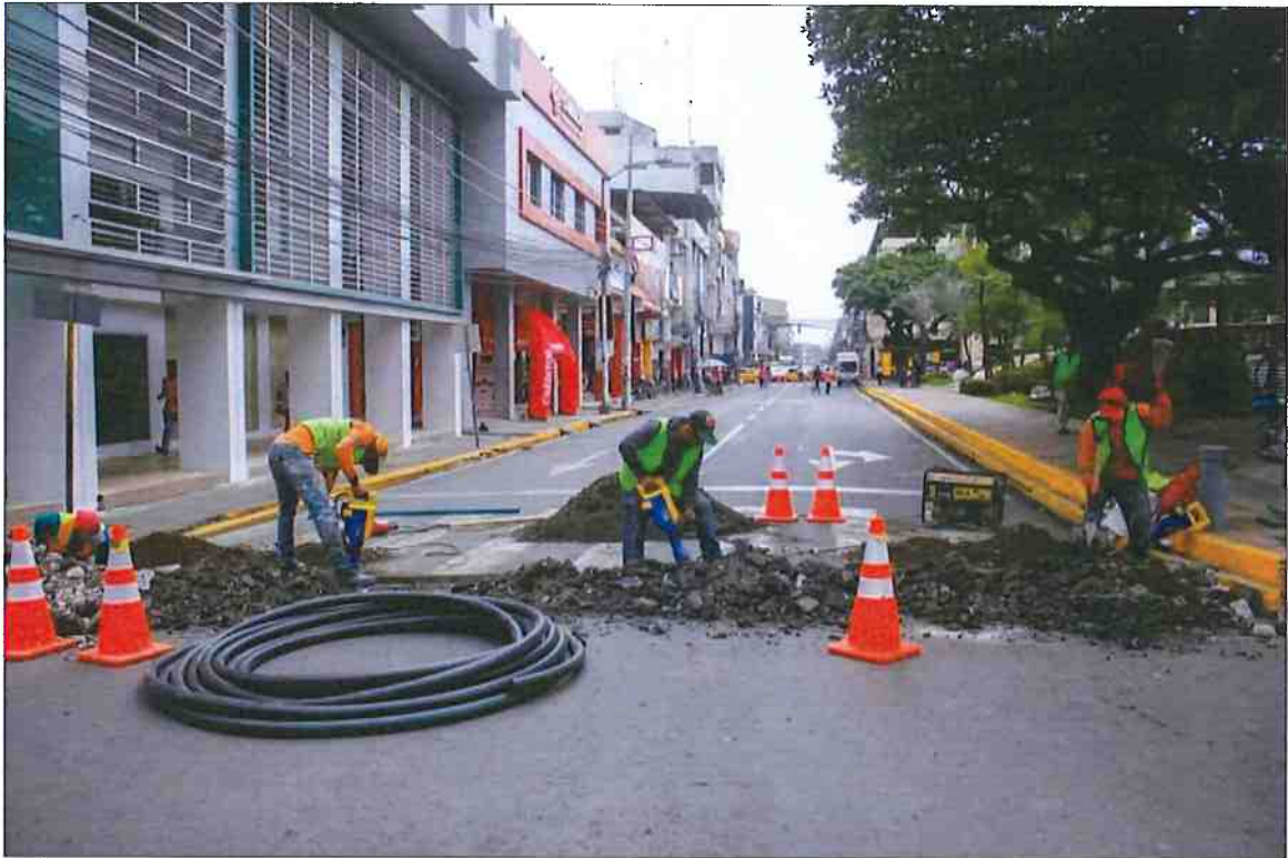
Ilustración 26: Trabajos de ejecución del proyecto de semaforización.
