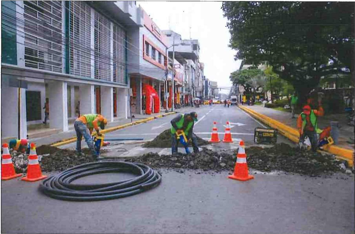
*Ilustración 26: Trabajos de ejecución del proyecto de semaforización.*
